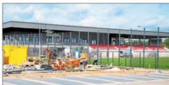
Fortschritte: Die Arbeiten im Außenbereich sollen in wenigen Wochen komplett fertig sein. Ein großer Teil des neuen, großen Parkplatzes ist bereits nutzbar.
