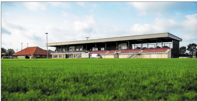
Großprojekt: Die Stadt investiert massiv in ihre Sportstätten. Auf dem Oyther Berg bekommt der VfL Oythe ein großes Vereinshaus mit Tribüne, Terasse und vielen Funktionsräumen. Fotos: Chowaniec
